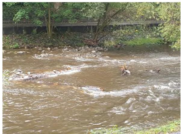
**Abb. 9** fixierte Dreiecksbuhnen aus Baumstämmen mit Kaltwasserpool an der Dreisam (Oberau) bei unterschiedlichen Wasserständen
